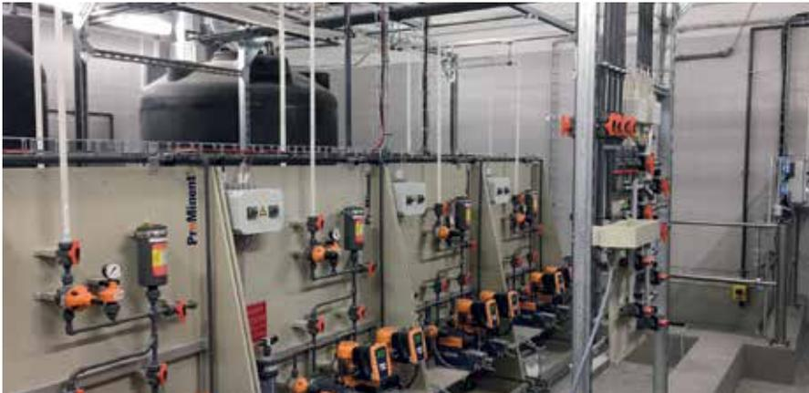
Dosiersysteme mit Motormembranpumpen der Baureihe Sigma dosieren im Wasserwerk Prag die fertige Natriumhypochlorit-Lösung bedarfsgerecht zur Desinfektion des Trinkwassers.
