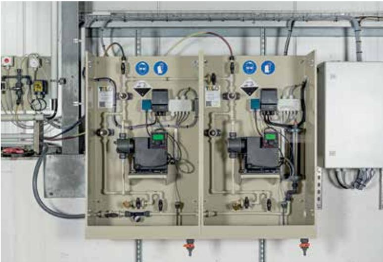
Die Systemintegrierte Dosierstation besteht aus zwei Dosierpumpen der Baureihe Smart Digital zur automatischen Anpassung an die Anlagenparameter.
