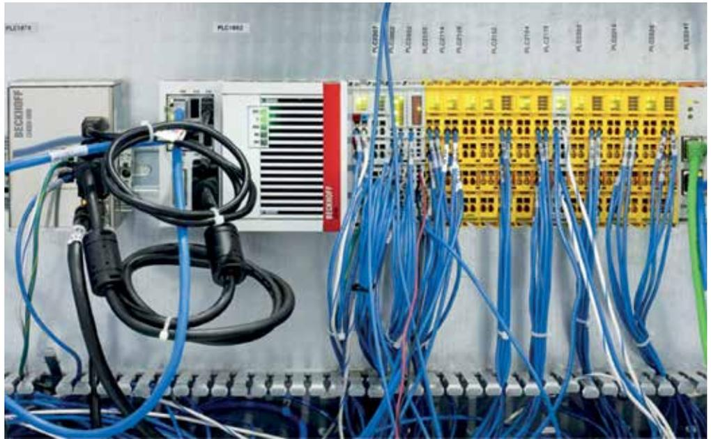
Der Embedded-PC CX5140 sorgt für schnelle Steuerung und hochgenaue Synchronisation.
