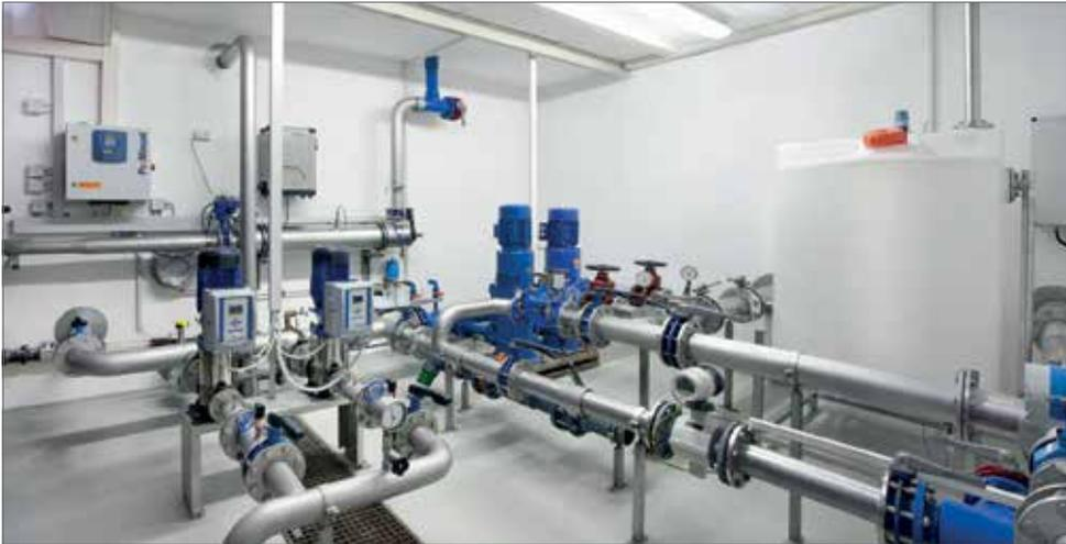
In einem Wasserwerk kommen UV-Anlagen Dulcodes LP zur UV-Desinfektion zum Einsatz.
