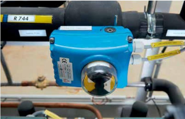
Das Umschaltventil schaltet die CO<sub>2</sub>-Kälteverbundanlage vom Normal- in den Tiefkühlbetrieb.
