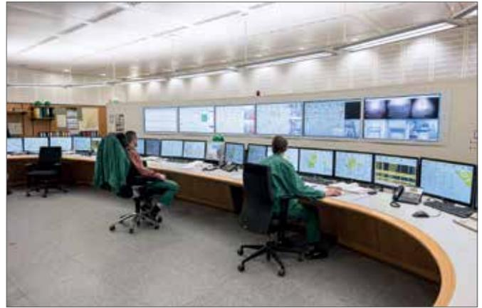
Das Prozessleitsystem Simatic PCS 7 erlaubt mittels Open OS die Integration aller Komponenten unterschiedlicher Hersteller sowie der gesamten Gebäudeleit- und Schalttechnik.
