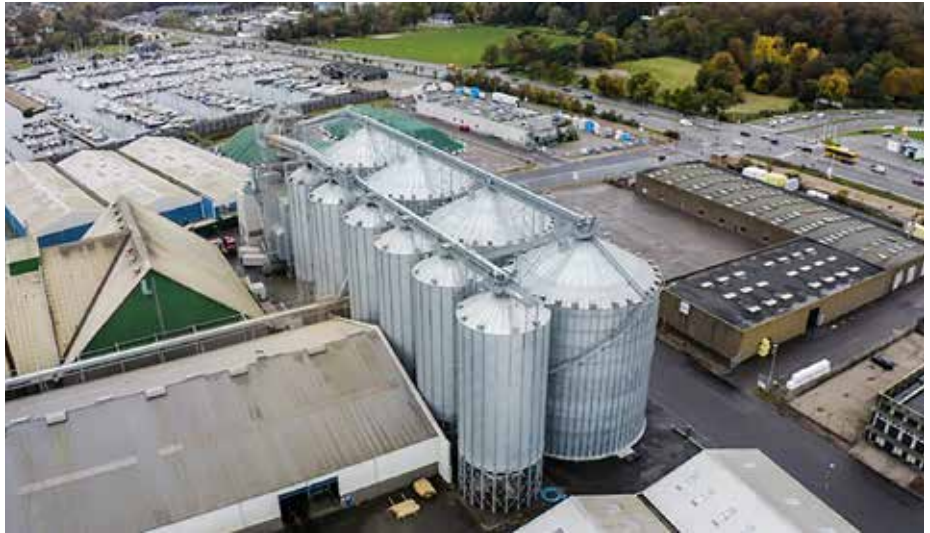
Die Kapazität des im Sommer 2019 in Fredericia in Betrieb genommenen Getreideterminals beträgt 40.000 Tonnen.
