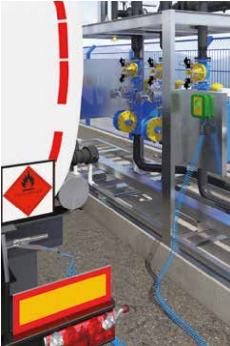
Das selbstüberwachende Erdungssystem Farado II wurde zur Erdung beim Befüllen oder Entleeren von mobilen Gebinden wie Tankfahrzeugen und IBC entwickelt.
