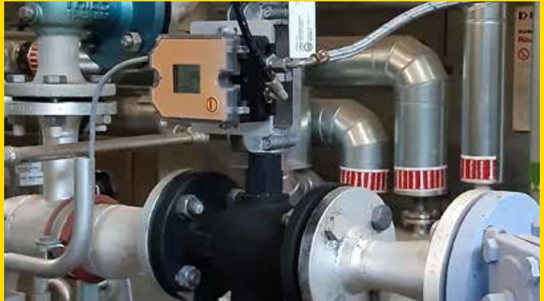
Durchgangs-Regelventile regeln den Durchfluss von Medien wie Wasser, Dampf oder Thermalöl (Bild: pneumatisches Dampf-Durchgangsventil Baelz 340 zur Druckreduzierung).
