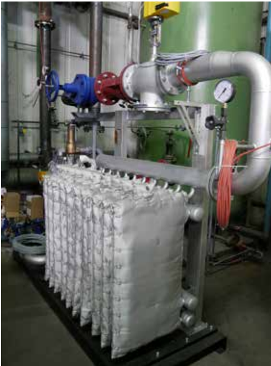
Die modulare Dampf-Wärmeübergabestation Modulo von W. Bälz besteht aus zehn isolierten Kupfermodulen.
