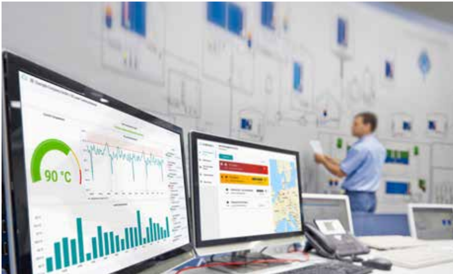
Volle Transparenz aufgrund eines standortübergreifenden Remote-Monitoring.
