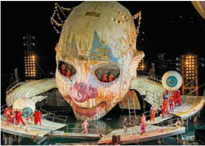
Die Bühne besteht aus einem festen und drei beweglichen Teilen, die von Seilzügen über elektromechanische Antriebe auf einem Schienensystem verfahren werden.
