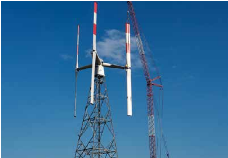
Aufbau der Vertikalwindkraftanlage Vertical Sky in Grevenbroich.
