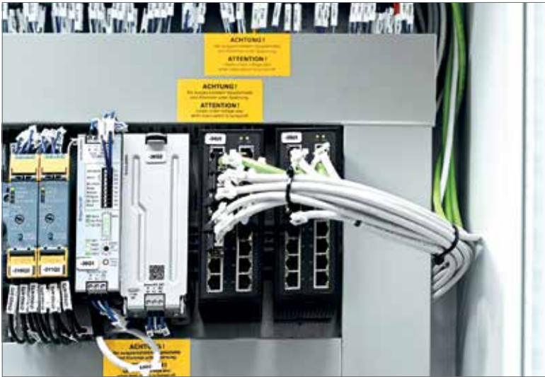
Beim Handling großer Datenmengen kommen die 16-Port-Switches von Murrelektronik zum Zuge.
