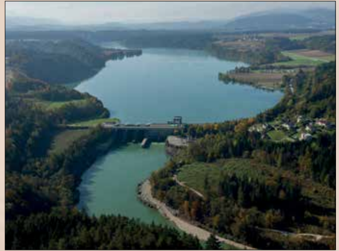
Das Laufwasserkraftwerk Edling erzeugt etwa 420.000 MWh Strom pro Jahr und beliefert die Liebensteiner Kartonagenwerke.
