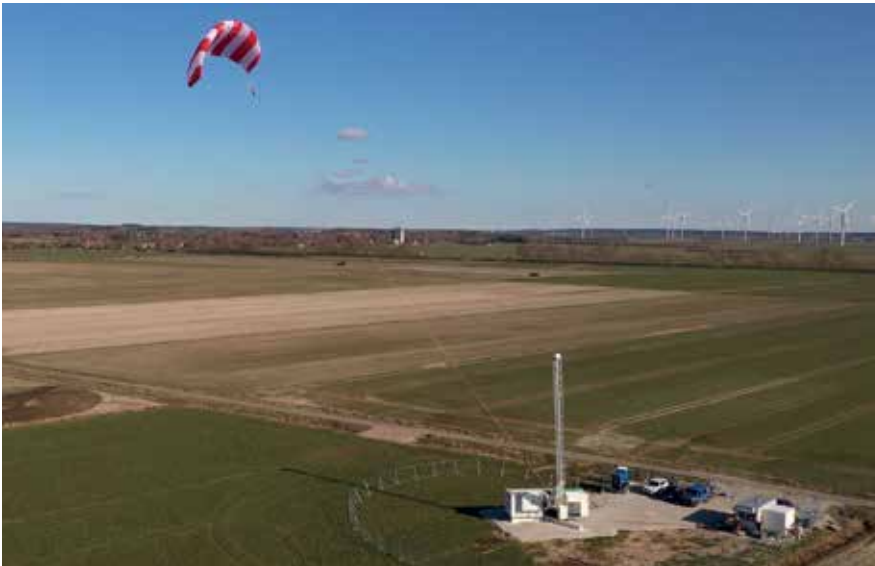
Energiegewinnung in 400 m Höhe: die Zugdrachenanlage von SkySails Power.
