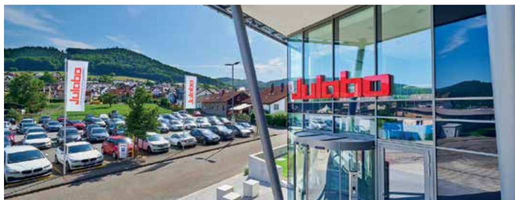
Das Verwaltungsgebäude der JULABO GmbH am Firmensitz in Seelbach.
