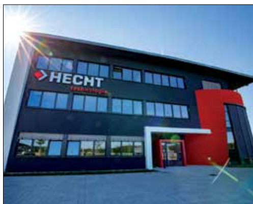
Kapazitätserweiterung - Fertigstellung neuer Standort
