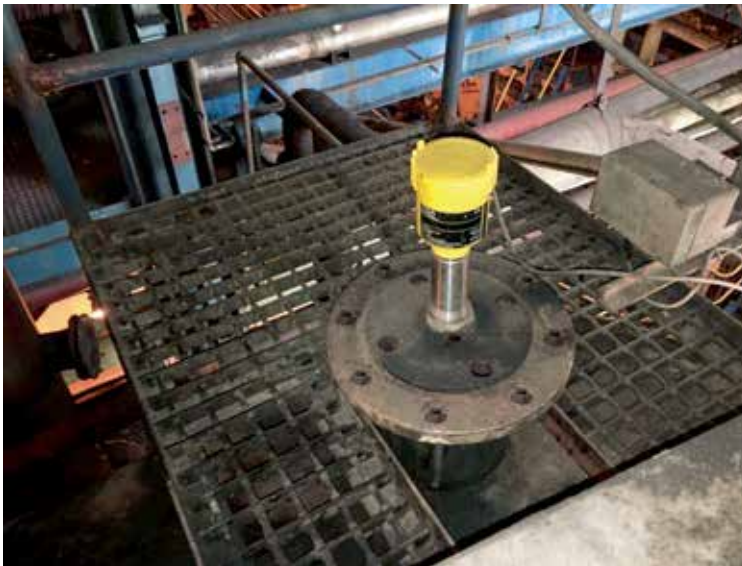
Der Vegapuls 64 in der Flanschausführung liefert auch im rauen Produktionsumfeld zuverlässige Füllstandsmesswerte.
