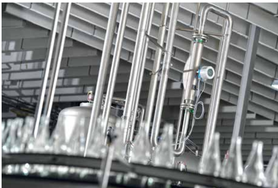
Der Promass F 100 erfasst die aus dem Tanklager entnommenen Alkoholmengen und berechnet die Alkoholkonzentration.
