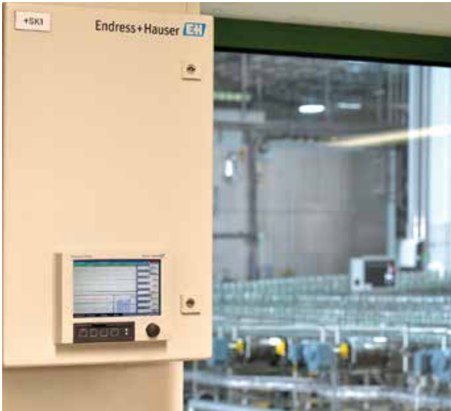
Im Bildschirmschreiber Memograph M werden alle Daten zentral gesammelt, gemanagt und weitergeleitet.
