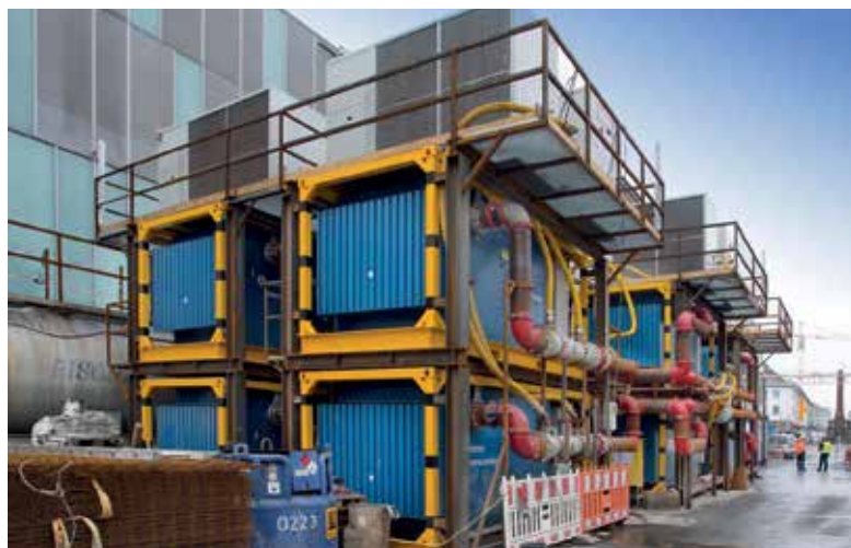
Die acht CVO4400 Einheiten der Aerzen Rental Division sind in Karlsruhe platzsparend zu einer zweistöckigen Einheiten kombiniert.
