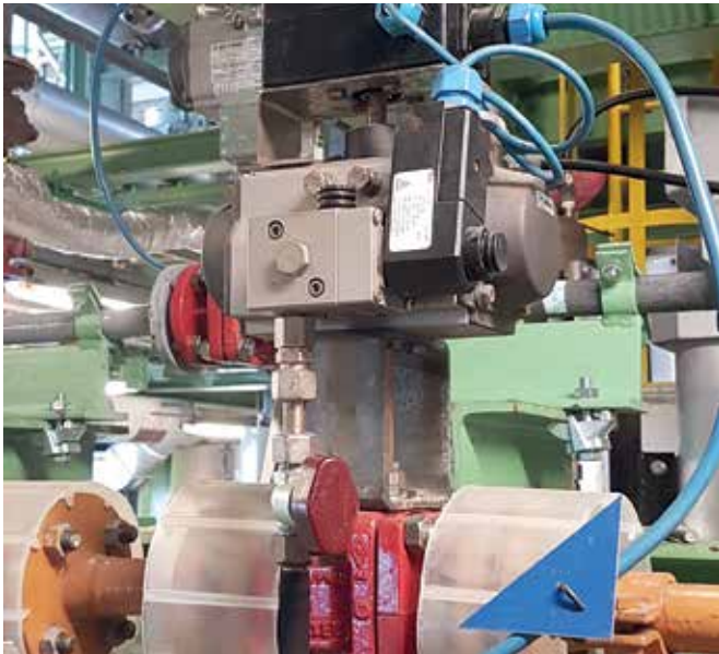
Rund 1.500 Magnetventile von Festo sind in der VZ-Anlage von Bayer im Einsatz.
