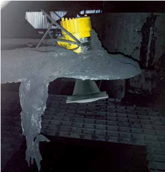
Der Sensor ist in dem Berg aus Kohlepulver beinahe nicht zu sehen. Trotzdem liefert er zuverlässige Messergebnisse.
