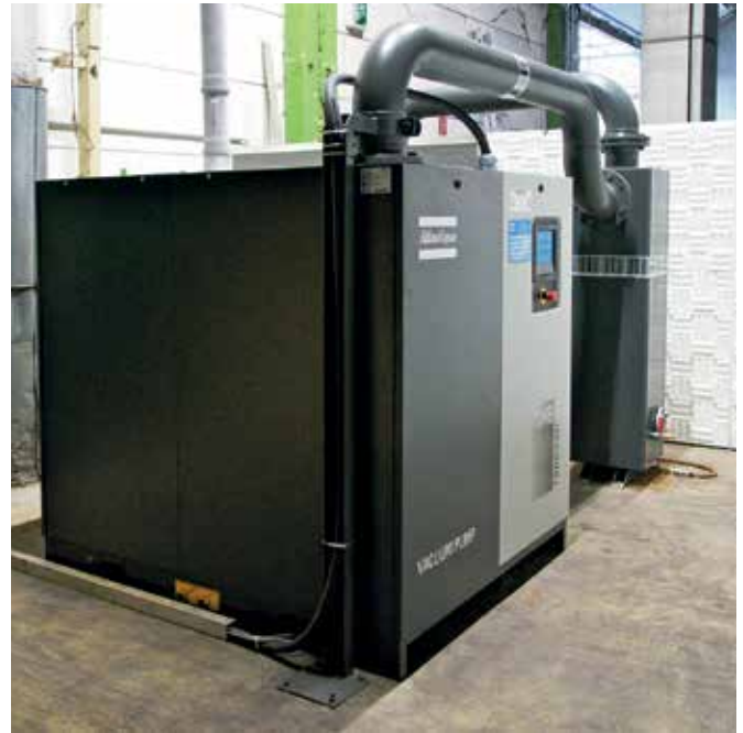
Die ölgeflutete Schraubenvakuum- pumpe ersetzt in Bad Wildungen zurzeit 15 Flüssigkeitsringpumpen.
