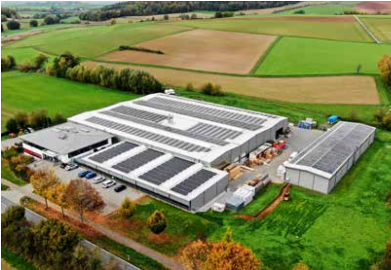
Frenger Systemen BV Heiz- und Kühltechnik im hessischen Groß-Umstadt hat über Jahre hinweg ihren Energieverbrauch optimiert.
