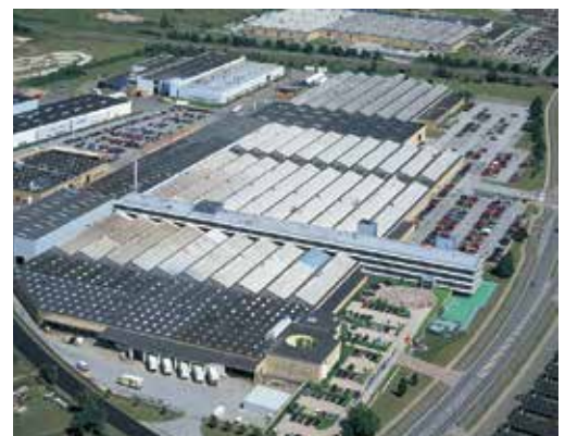
GRUNDFOS Konzernzentrale, Bjerringbro
