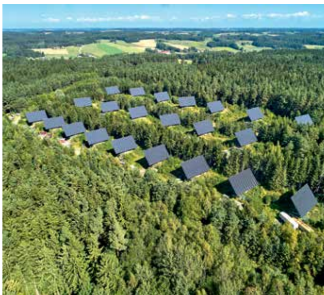
22 Photovoltaiktracker thronen auf den Bunkern eines ehemaligen Militärgeländes, welches unter anderem früher als Munitionslager diente.
