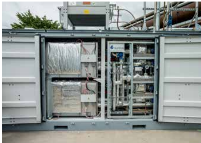
Die Anlage soll bis Ende 2022 mindestens 13.000 Stunden in Betrieb sein und etwa 100 t Wasserstoff von hoher Reinheit (99,98 Prozent) liefern.
