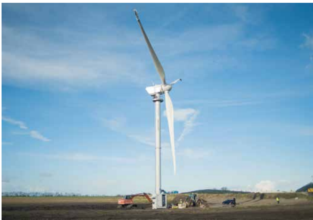
Die 250-kW-Windturbine hat eine Nabenhöhe von gut 28 m und eine Gesamthöhe von 50 m.
