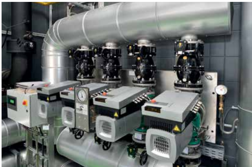
Die Hochleistungswasserpumpen verfügen über eine modulierende, elektronische Leistungsanpassung, die Drehzahlen exakt an dem erforderlichen Volumenstrom ausrichtet.
