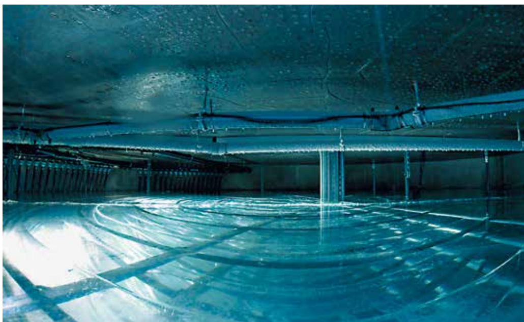
Energiewunder: Im Phasenübergang von 0 °C kaltem Wasser zu 0 °C kaltem Eis steckt so viel Energie, wie benötigt wird, um Wasser von 0 auf 80 °C zu erwärmen.
