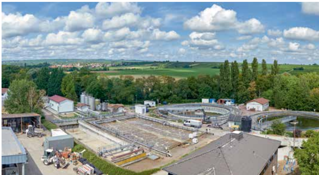
Überblick über die Kläranlage Monsheim, in die die drei rheinland-pfälzischen Verbandsgemeinden Kirchheimbolanden, Göllheim und Monsheim ihr Abwasser einleiten.
