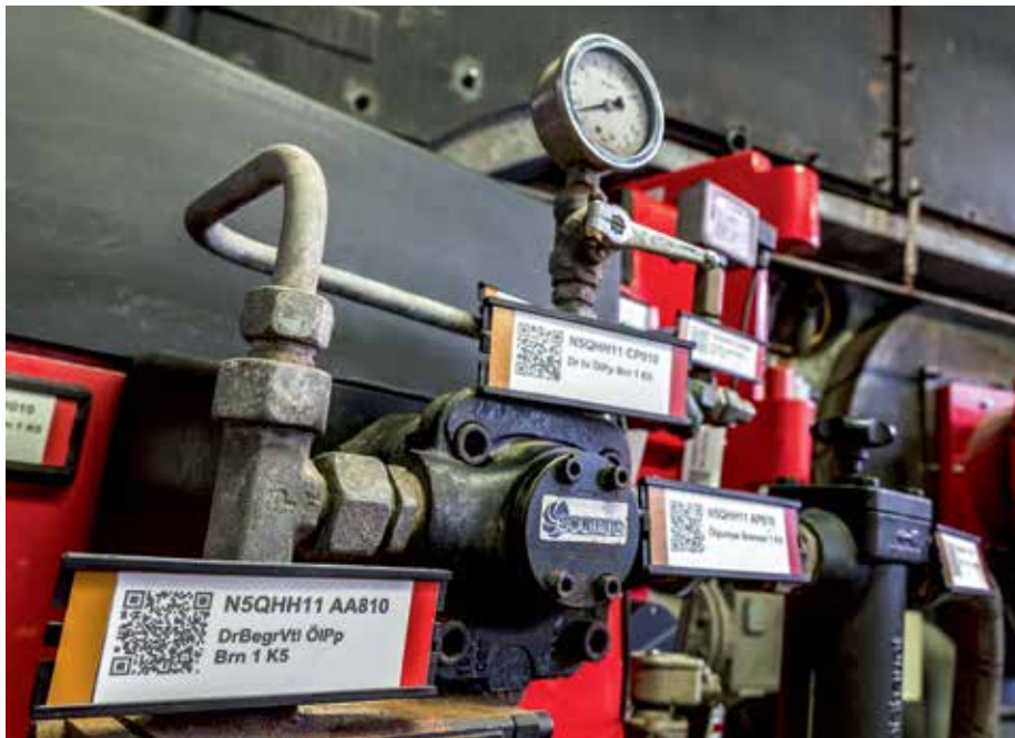
Jedes Aggregat auf lange Sicht eindeutig markiert und dokumentiert: K+S hat am Standort Sigmundshall ein Kraftwerk-Kennzeichensystem eingeführt.
