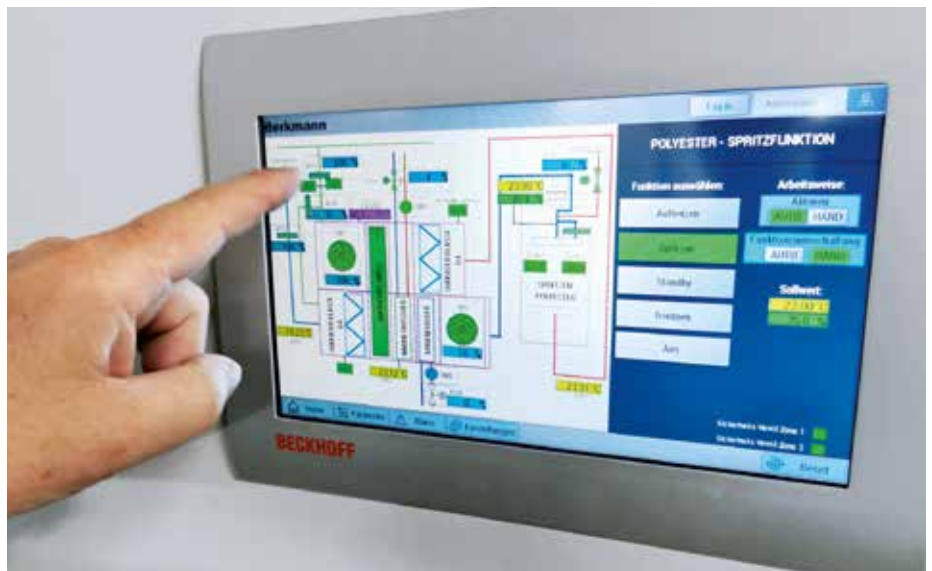
Die mit dem HTML5-basierten TwinCAT HMI erstellte Visualisierung und Bedienung der Lackieranlage erfolgt übersichtlich und komfortabel am Beckhoff Einbau-Touchpanel CP690x.
