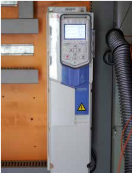
Der Frequenzumrichter ACQ580 verfügt über eine integrierte Pumpenreinigungsfunktion.
