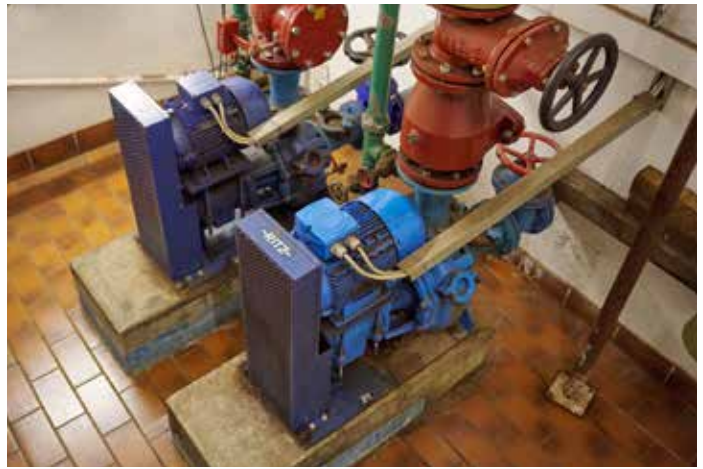
Der Motor von Pumpe 2 (rechts) wurde als erster mit einem ACQ580 geregelt.
