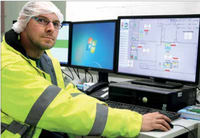
In seiner Leitwarte hat Andreas Jentgens unter anderem die Druckluftstation sowie die Kältemaschinen im Blick.
