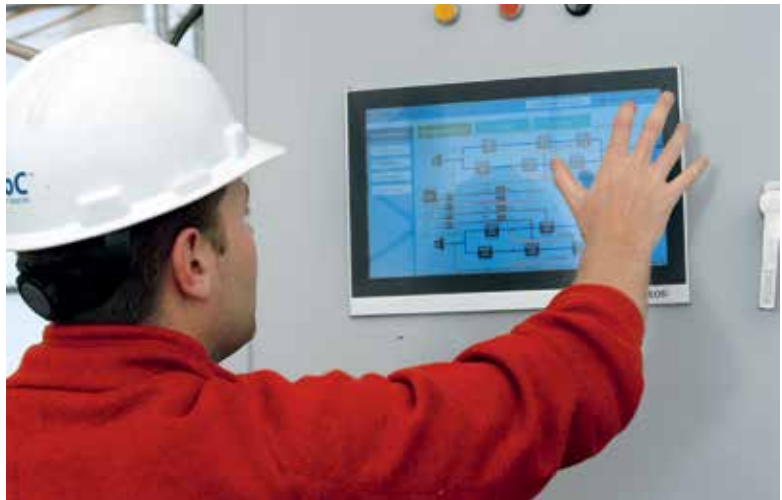
Auf dem Multitouch-Panel-PC CP2216 von Beckhoff läuft die HMI-Software von EOSi und die Steuerungssoftware Twincat.
