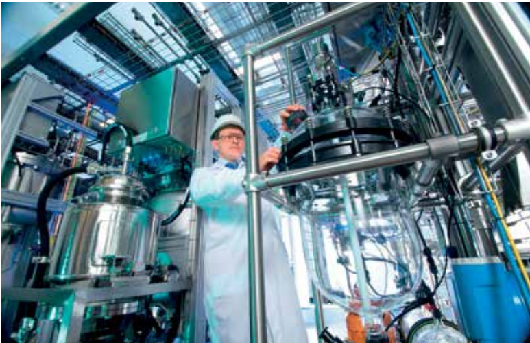
Demonstrator bei Bayer: Modulare Anlagen sind hierarchisch aufgebaut.
