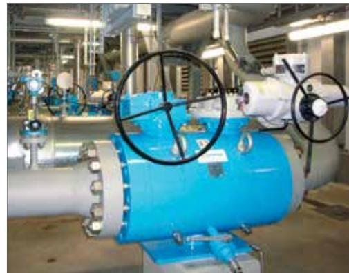
TBV: Doppelter Kugelhahn - doppelte Sicherheit
