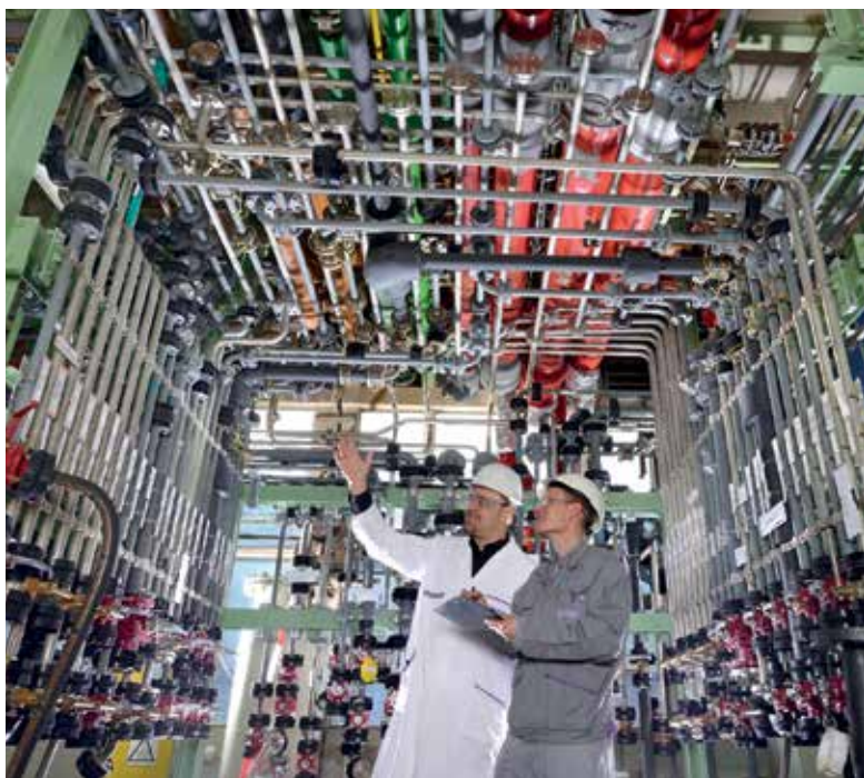
In Rohrbahnhöfen laufen die Rohrleitungsanschlüsse zahlreicher Apparate zusammen. Verschaltungen lassen sich so einfach und schnell realisieren.
