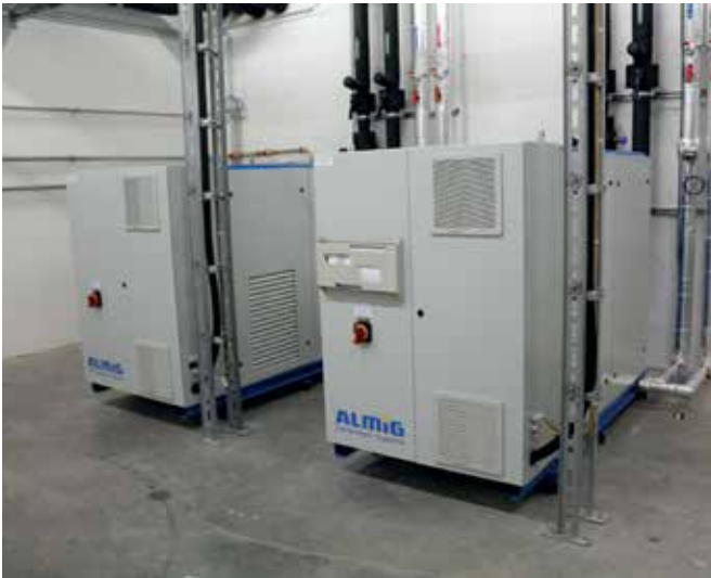
Losan Pharma setzt auf zwei direktgetriebene, drehzahlgeregelte Schraubenkompressoren der Type Variable 55 von Almig.
