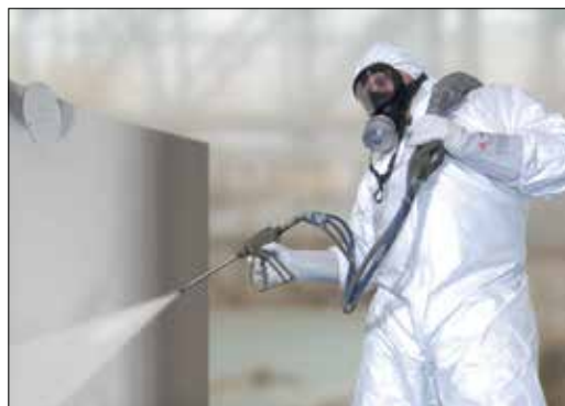
Korrosionsschutz durch Beschichtung, Gummierung oder Ausmauerung – je nach Anwendung.
