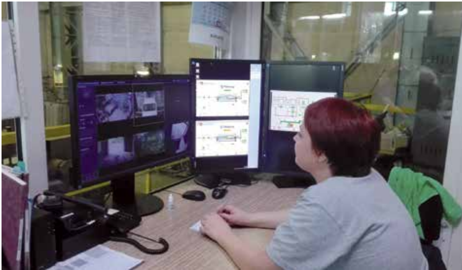
Ein Blick in das Kontrollzentrum: Die Bedienung der Zentrifugen ist mit der automatischen Prozessüberwachung angenehm.
