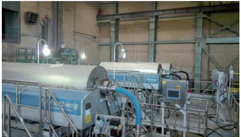
Dekanterzentrifugen sind geschlossene Systeme, daher sind Geruchsemissionen auf ein Minimum reduziert.
