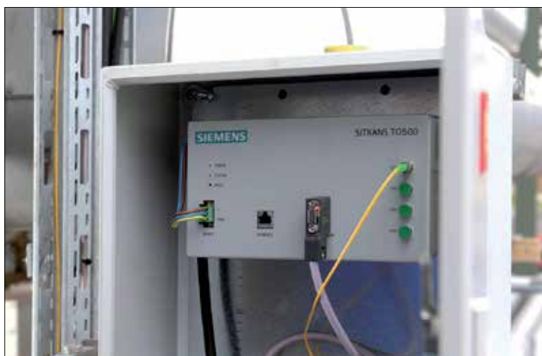
Der Temperaturmessumformer Sitrans TO500 ermöglicht es, Temperaturprofile mit bis zu 192 Messstellen entlang faseroptischer Lanzen zu erstellen.
