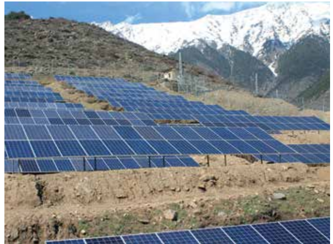
Zusätzlich zu einer Wasserkraftturbine bezieht das afghanische Dorf seinen Strom aus dem 200 kW starken Solarfeld.
