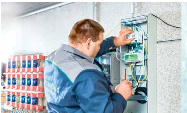
Die Zähler werden statt per Kabel über ein TLS-fähiges Funksystem mit den Gateways verbunden.
