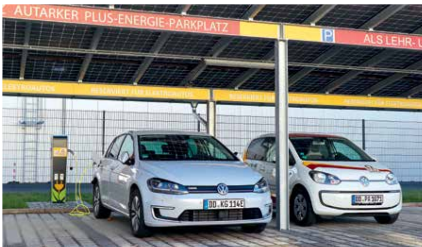
Solarwatt und Kiwigrid haben einen energieautarken Parkplatz mit Ladesäulen für Elektrofahrzeuge entwickelt.
