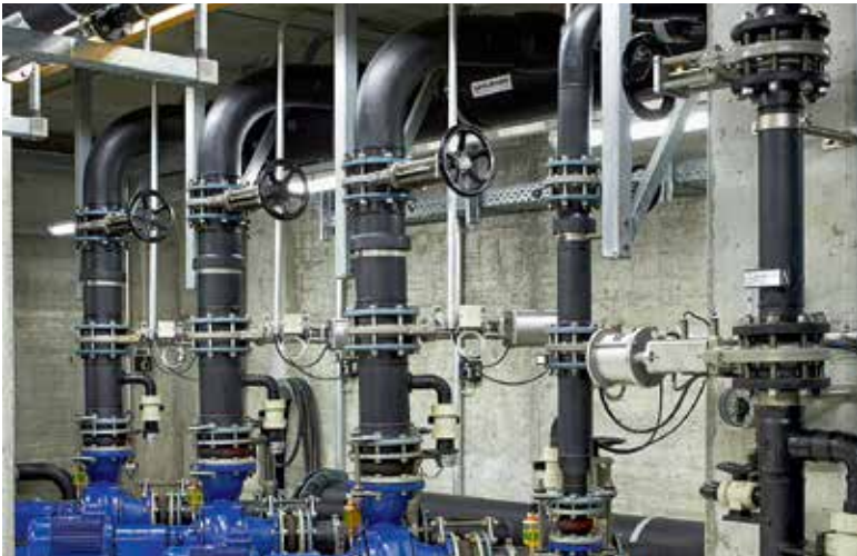
Rohrleitungen aus Kunststoff bieten sich sowohl für konventionelle Kraftwerke als auch für regenerative Formen der Energieerzeugung an, die ebenfalls einen Wasser-Dampf-Kreislauf einsetzen, also etwa Biomassekraftwerke.
