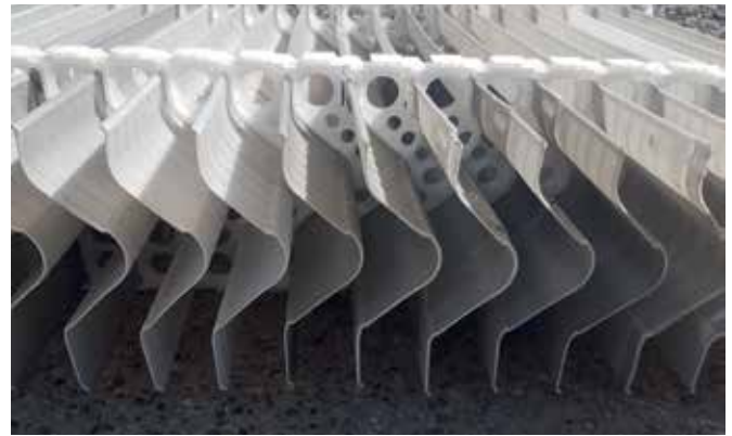
Der eingesetzte Tropfenfang senkt den Verlust von Wasser.
