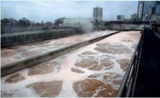
Die aerobe biologische Stufe der Abwasserreinigungsanlage eines Papierproduzenten in Schwedt.
