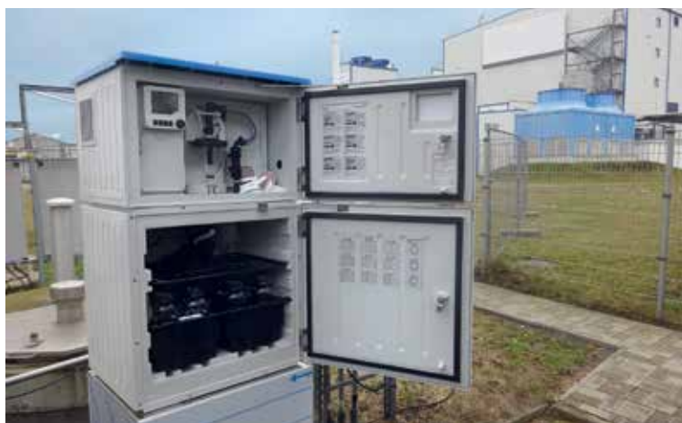
Probenahme- und Analysestation für die Überwachung der Schmutzabwassereinleitungen in das Abwassernetz des Chemieparks
