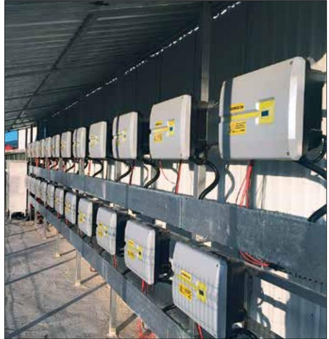
Neun Piko-Wechselrichter mit einer Leistung von 200 kWp sind installiert worden.
