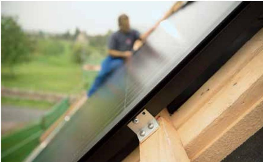
Die Indach-Module sind so groß wie gängige Solarmodule und ersetzen die gängige Dacheindeckung.
