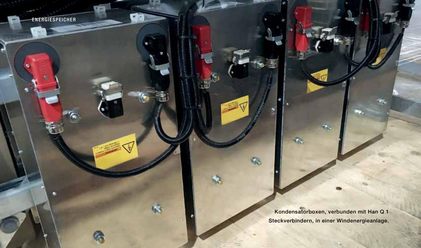
Kondensatorboxen, verbunden mit Han Q 1 Steckverbindern, in einer Windenergieanlage.
