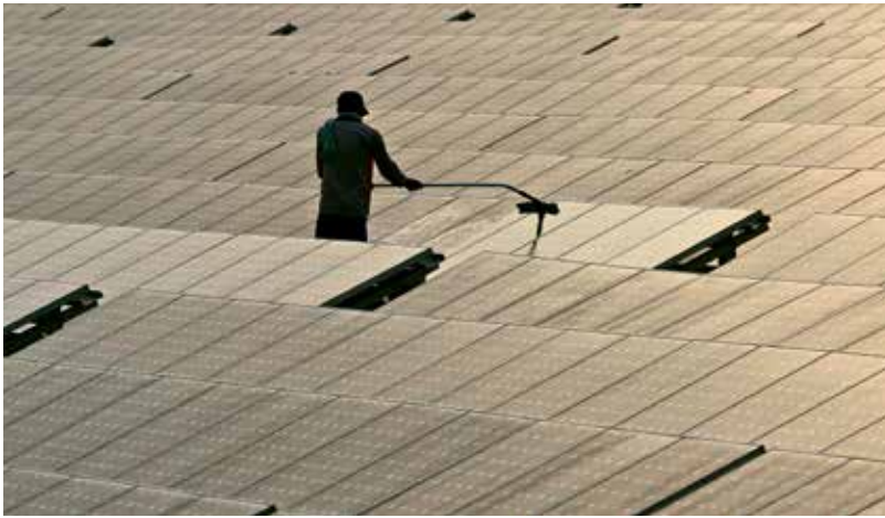
Die Säuberung einer PV-Anlage schlägt in der Freifläche je nach Größe im Schnitt mit circa 1,50 bis zwei Euro pro Kilowattstunde zu Buche.
